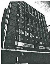
宝酒造本社が入るビル（京都市下京区）
